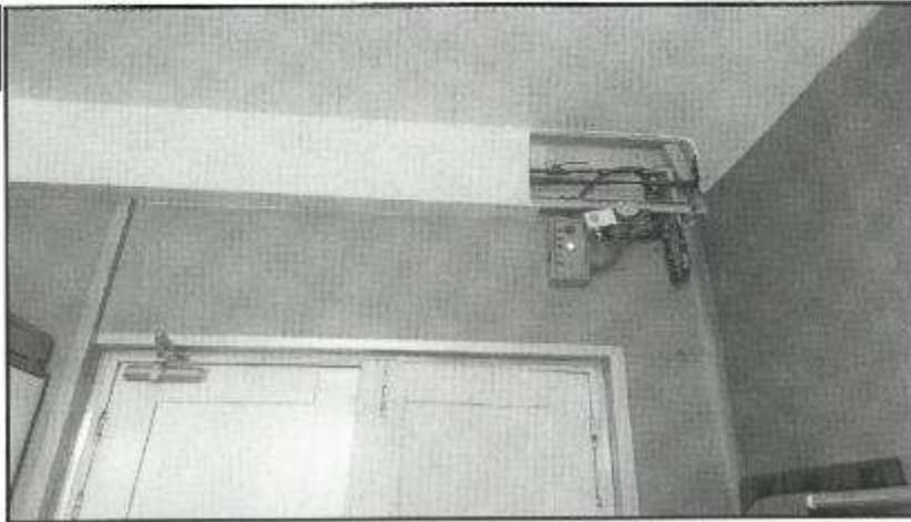
EN ESTA TOMA FOTOGRÁFICA SE APRECIA LUGAR DONDE SE VA INSTALAR UNA FALSA VIGA DE TABIQUERÍA DRYWALL CON TAPA DE PVC PARA EL CONTROL DE MANÓMETRO EXISTENTE
